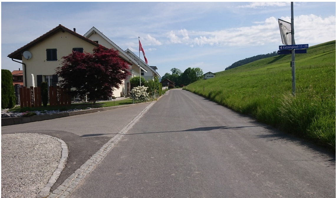
Abbildung 11 Böschung östlich des Katzengässlis
