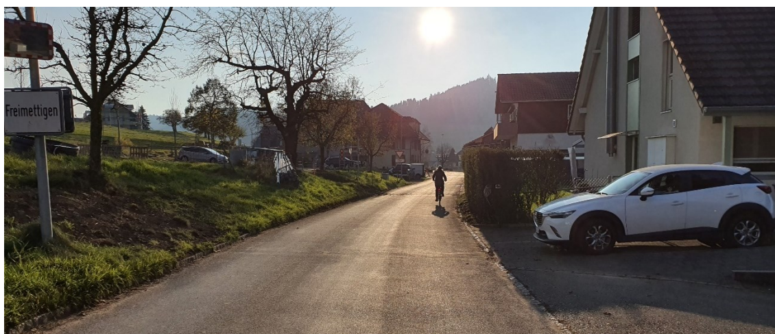
Abbildung 12 Böschung und Privatgrundstücke im Katzensgässli
